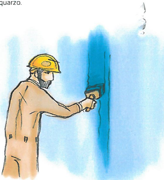
fig. 57: Applicazione del Primer a pennello
